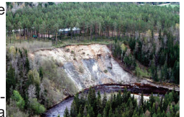
Pågående ras Foto: Örjan Hansson
